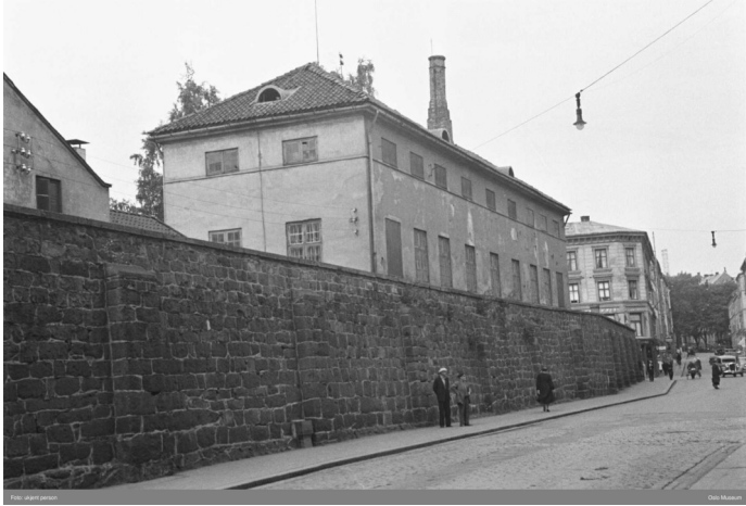
Tukthusmuren nedover langs Bernt Ankers gate fra Torggata. 1938. Fotograf ukjent. Eier: Oslo Museum.
